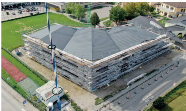
Baustelle Kinderhaus: Fenstermontage, Versickerungsanlage, Stahlbauarbeiten, Abstimmung Dachdeckerarbeiten
