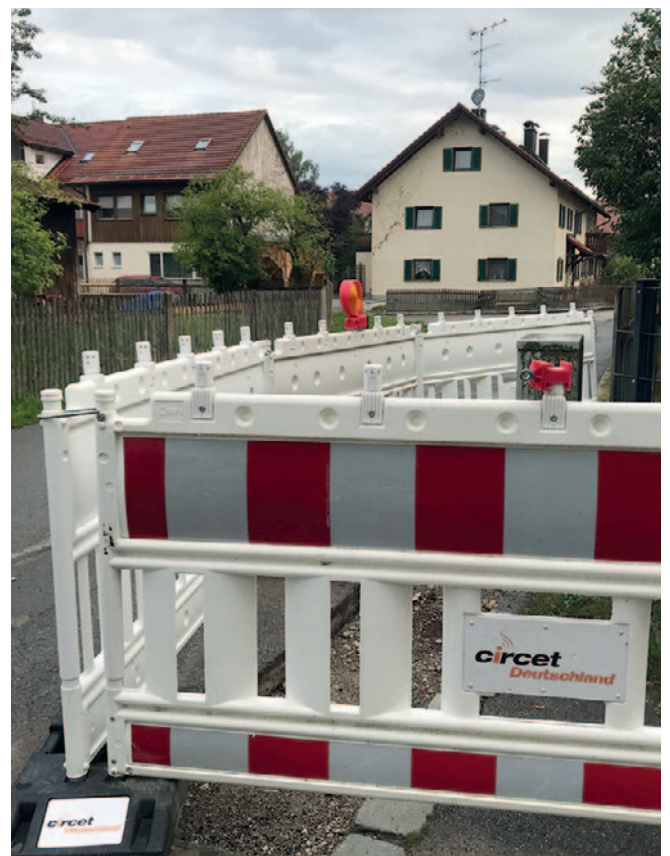
Glasfaser-Ausbau: Leitungen werden verlegt
